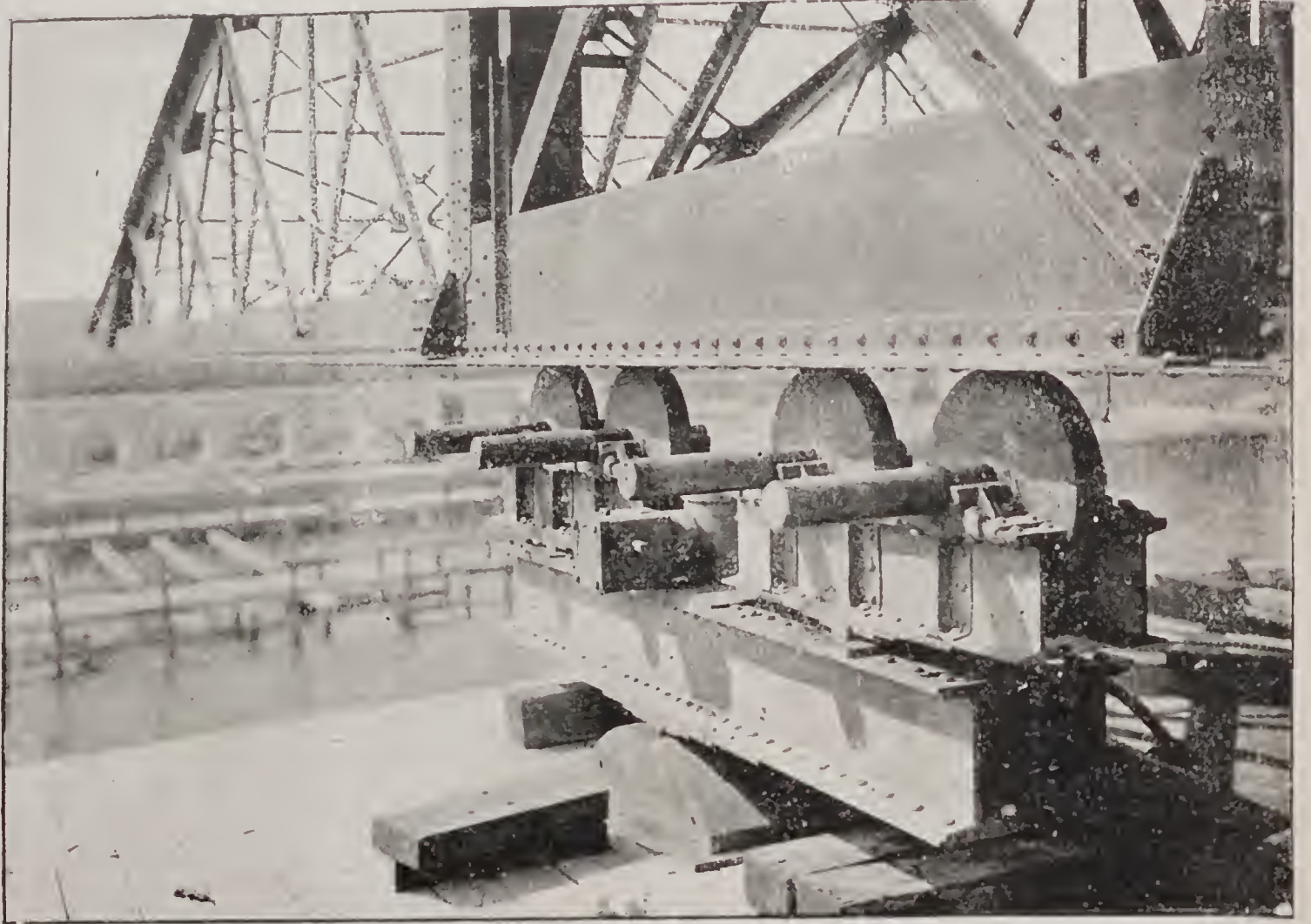
Les galets de roulement pour le lancement de la passerelle.
